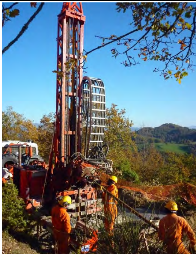
Perforazione di un pozzo per sismometro borehole.
